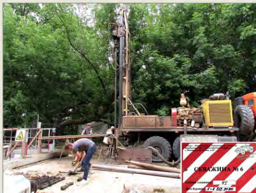
Буровая площадка скважины №6 в верхней части эскалаторной галереи на Воробьевых горах. Процесс бурения и осмотр керна. Справа внизу: табличка скважины с выходными данными (фото С.Ю. Миленкиной)
