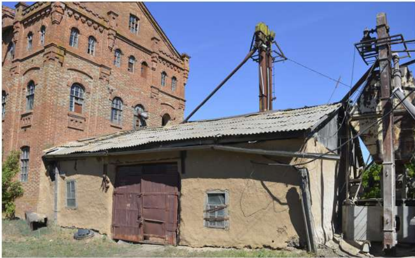
Заброшенное здание старинной паровой мельницы в селе Дьяковка 1911 года постройки (экспедиция «Флотилия плавучих университетов – 2018»).
